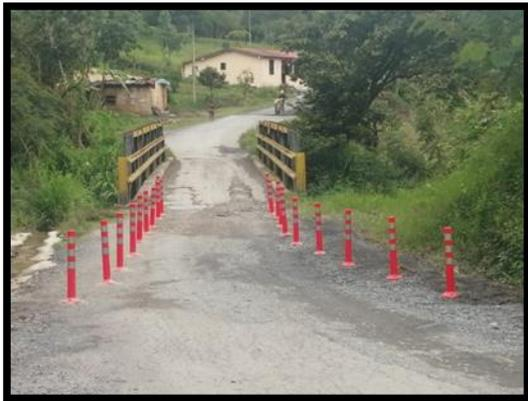
Hitos para restricción de paso sobre el puente
